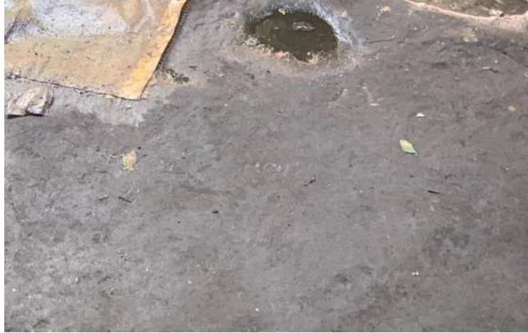
Gambar 3. Kondisi setelah implementasi ringkas
