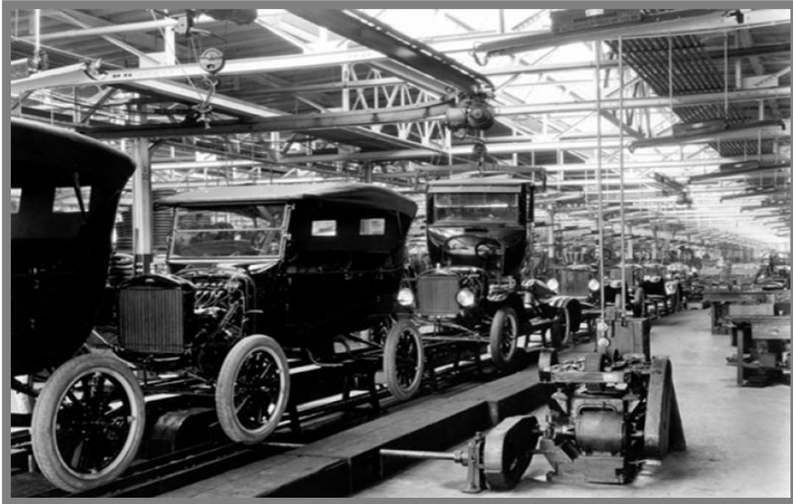
Gambar 6.3 Lini Perakitan Kendaraan Ford Model T (1912)
