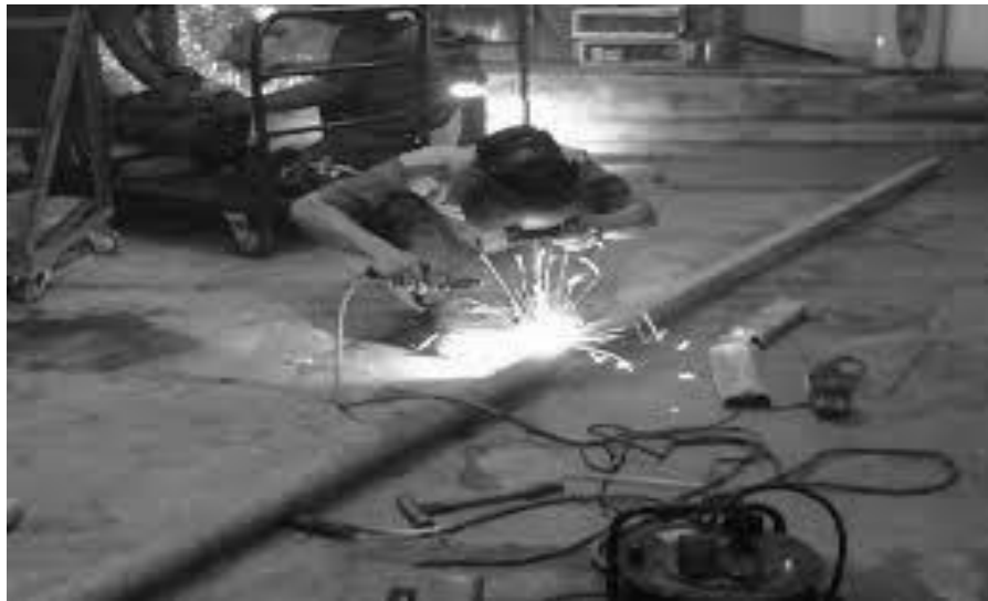
Gambar IV.13 Tahap Joining (Sumber: PT Laser Metal Mandiri, 2016)
