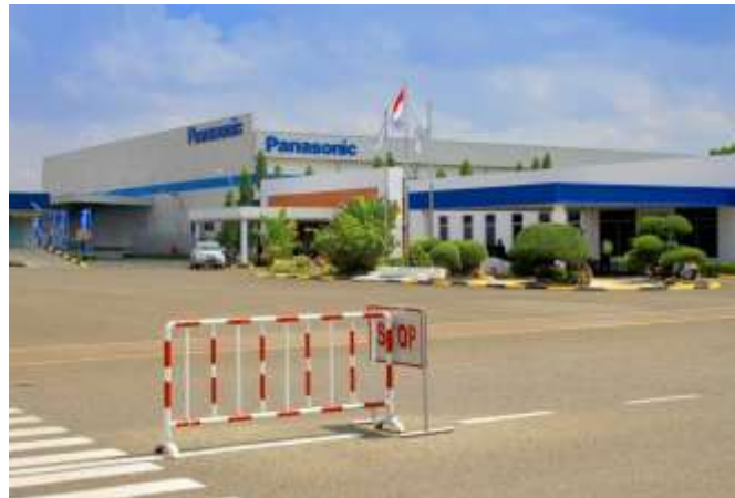
Gambar IV.1 Ilustrasi Gedung PT Panasonic Gobel Energy Indonesia Sumber: PT Panasonic Gobel Indonesia (2016)
