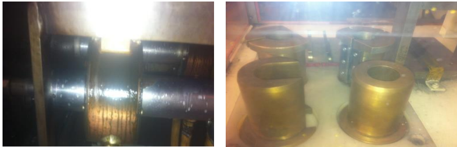
Gambar 4.14 Sebelum penggantian coil baru (kiri) dan setelah coil baru diganti (kanan)
