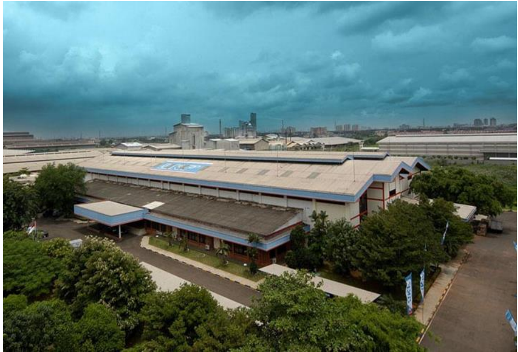
Gambar IV.2 Gambar Tampak Atas PT SKF Indonesia (Sumber : PT SKF Indonesia)
