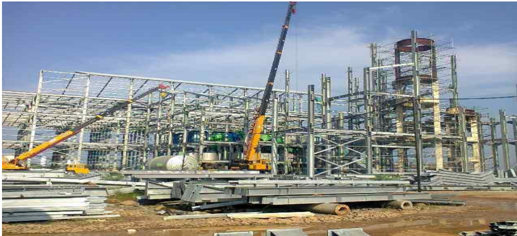
Gambar 4.2 Proyek Steel Structure pada Selago Makmur Sumber: (PT Gerbang Saranabaja)
