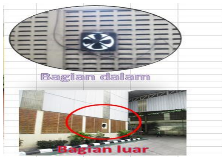
Gambar 5.6 Kondisi Pendingin Ruangan Setelah Perbaikan (Sumber: PT Mekar Armada Jaya)
