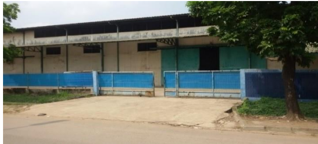
Gambar IV.1 Pabrik PT Kreasi Presisi Metalindo Plant 2 di Jababeka II (Sumber: PT Kreasi Presisi Metalindo, 2016)
