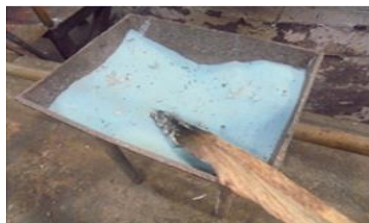
Gambar 5.2 Takaran Modifier Kayu (Sumber: PT XYZ, 2017)
