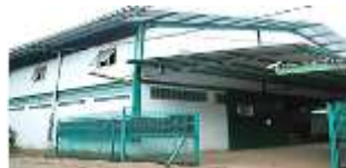
Gambar 4. 4 Plant 2 PT Rekadaya Multi Adiprima (Sumber: PT Rekadaya Multi Adiprima)
