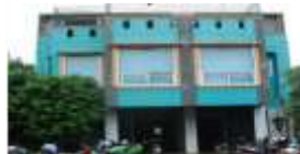
Gambar 4. 7 Plant 5 PT Rekadaya Multi Adiprima (Sumber: PT Rekadaya Multi Adiprima)
