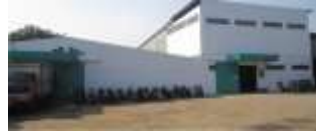
Gambar 4. 9 Plant 7 PT Rekadaya Multi Adiprima (Sumber: PT Rekadaya Multi Adiprima)
