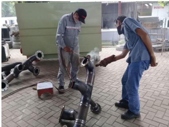
Gambar 4. 10 Proses Penyambungan Flange dan Pipa (Sumber: PT Astanita Sukses Apindo)
