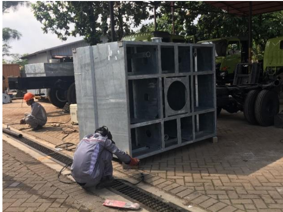
Gambar 4. 9 Proses Pemasangan Partisi (Sumber: PT Astanita Sukses Apindo)
