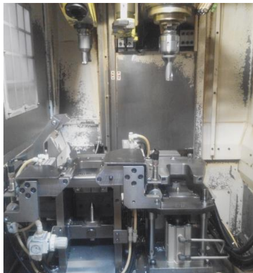
Gambar 4.11 Mesin OP 13 ( Boring Pin Hole )
