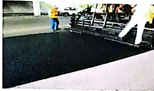
Gambar 2.6 Bentuk aspal polimer pada pembuatan jalan
