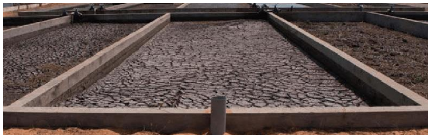
Bangunan Sludge Drying Bed
