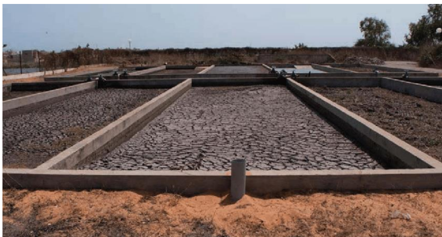
Gambar 4.1.4 Sludge Drying Beds milik PT XYZ (Sumber : Pengumpulan data)
