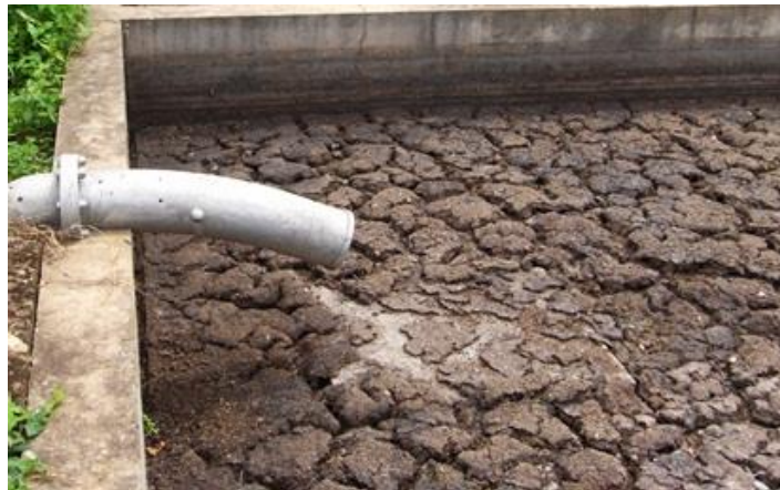
Gambar 4.1.5 Input Sludge Drying Beds (Sumber : Pengumpulan data)
