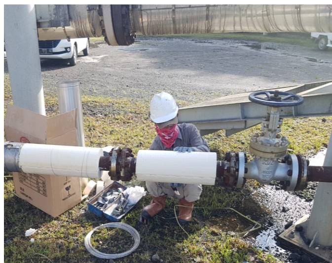
Gambar 4.3 Proses Pemasangan Calcium Silicate Sumber: PT Krazu Nusantara
