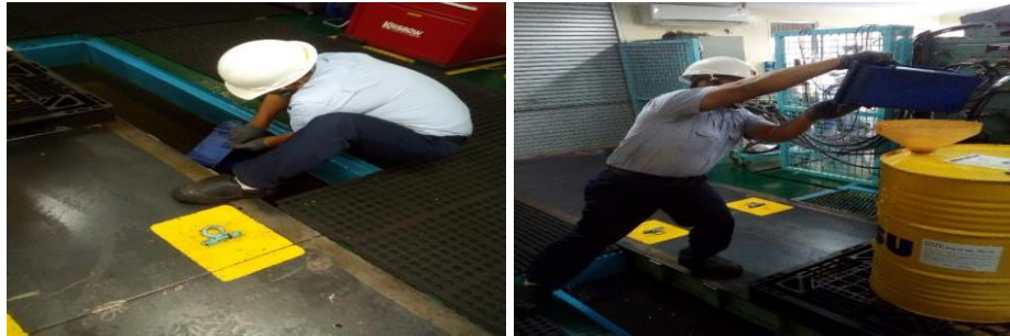
Gambar 4.33 Menguras Oli Dengan Bak Kotak Kecil (Sumber: PT Komatsu Indonesia)
